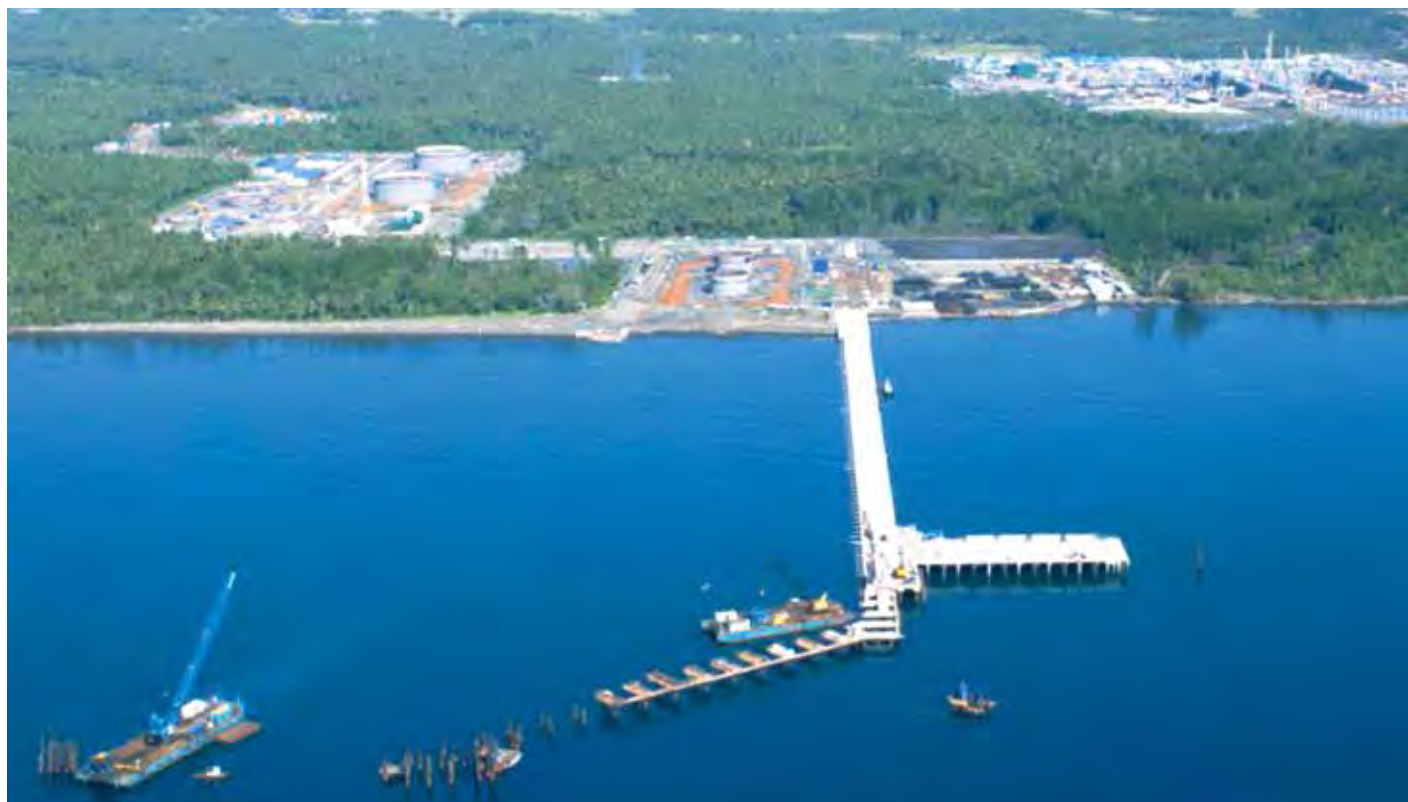
Konstruksi pembangunan Proyek Gas Senoro yang hampir selesai di Sulawesi Tengah. The nearly completed construction of the Senoro Gas Project in Central Sulawesi.
